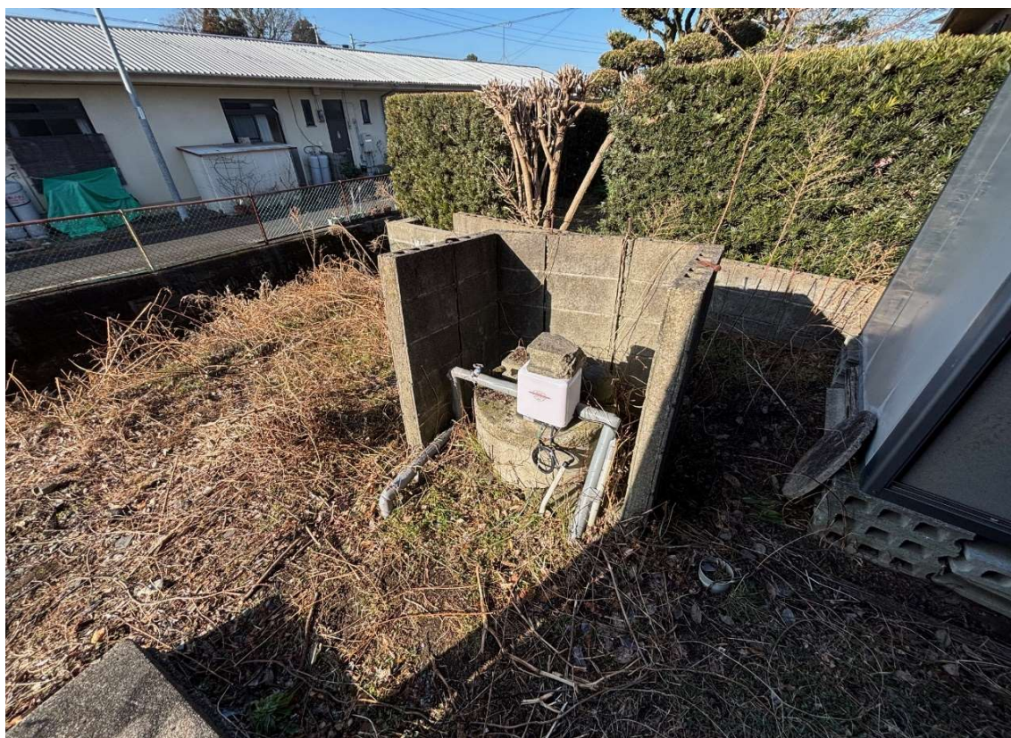
【井戸ボーリング】
