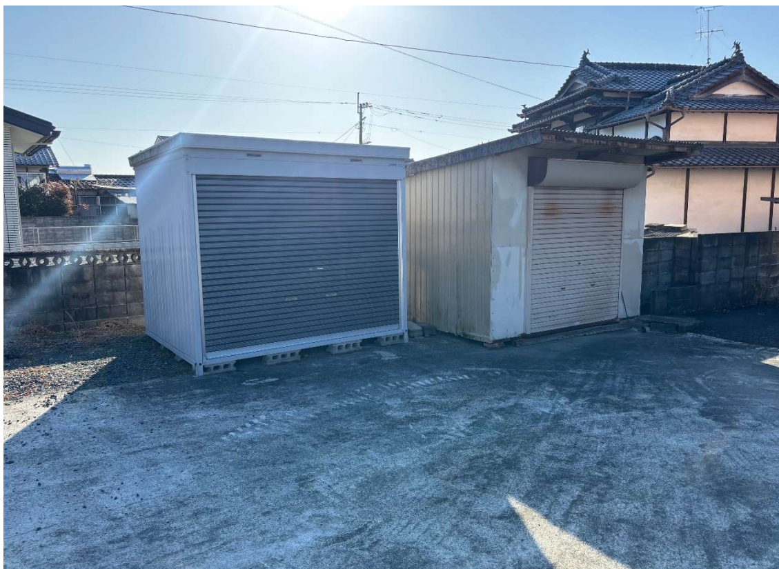
【付属設備①東側倉庫 2 カ所】
