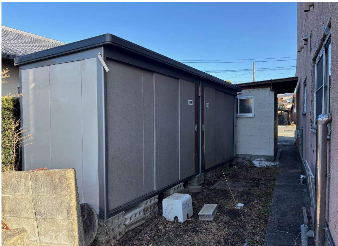
【付属設備③西側倉庫 2 カ所】
